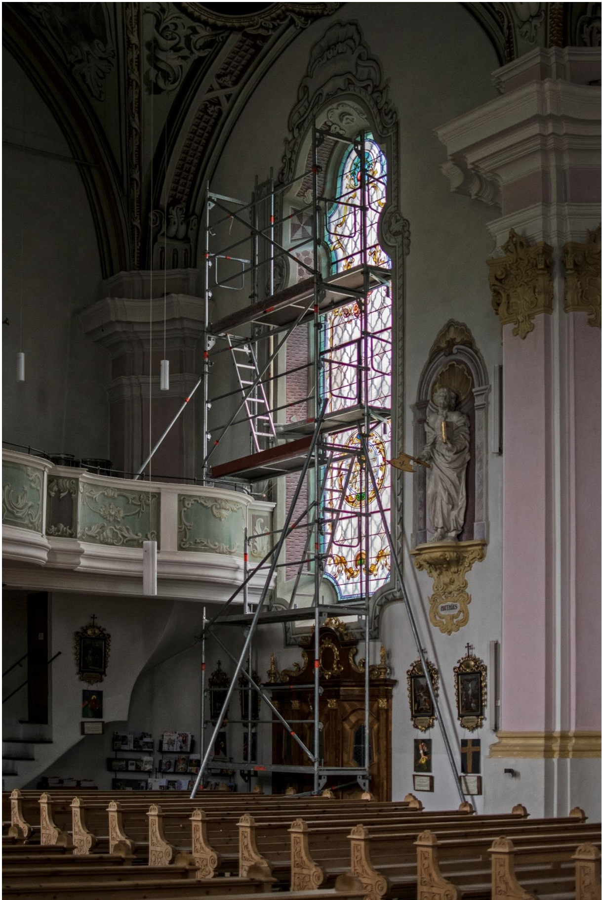
Fenster nV während der Arbeiten
