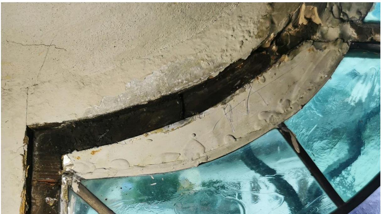
Fenster nV während dem Ausbau: Aufgelötete Blechblenden zu Kaschierung von zu kleinem Bleifeld
