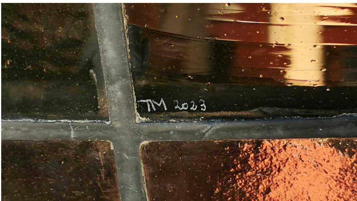
Ausgetauschtes Glasstück mit der Gravur „TM 2023“ zur Sichtbarmachung, dass es sich um ein Duplikat handelt
