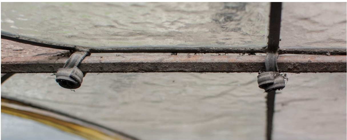
Originale Bleihaften vor dem Fensterausbau
