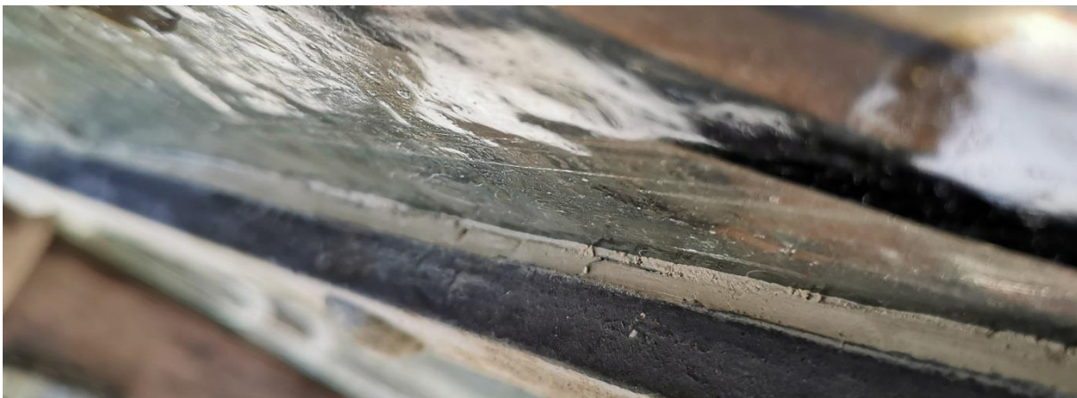
Im Zuge der Restaurationsarbeiten von außen mit Leinölkitt aufgefülltes Quereisen (Nordseite).
