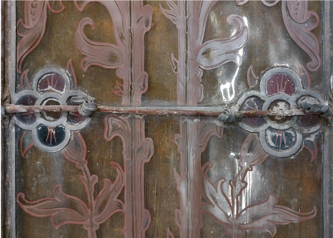
Scurriles Windeisen aus Holz-Zweig beim Lüftungsflügel in Fenster nl
