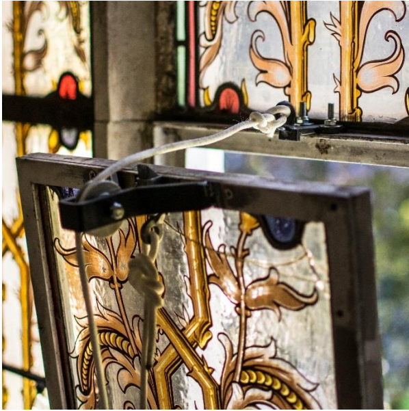
Neu-hergestellter Mechanismus zum Öffnen und Schließen in Fenster nl
