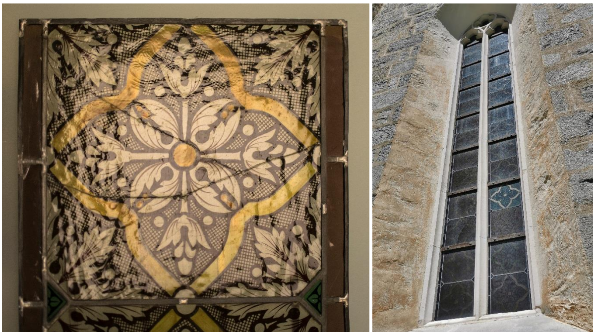
links: Gesicherte Bruchteile mit Araldite 2020 rechts: Außenansicht vor der Restauration. Das unzufriedenstellende Duplikat ist gut erkennbar.
