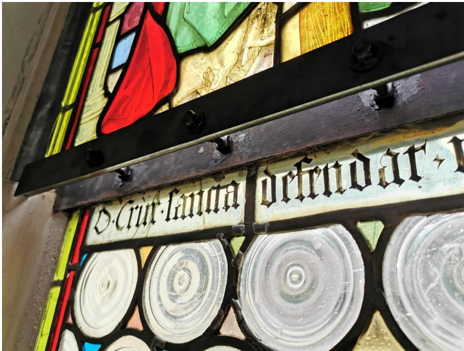
Detail der isothermalen Schutzverglasung nach der Restaurierung. Am linken Bildrand sichtbar: Es wurden rechts und links des Bleifeldes Walzblei-Streifen als Blenden an den Messingrahmen gelötet um das einfallende Licht abzuschatten.
