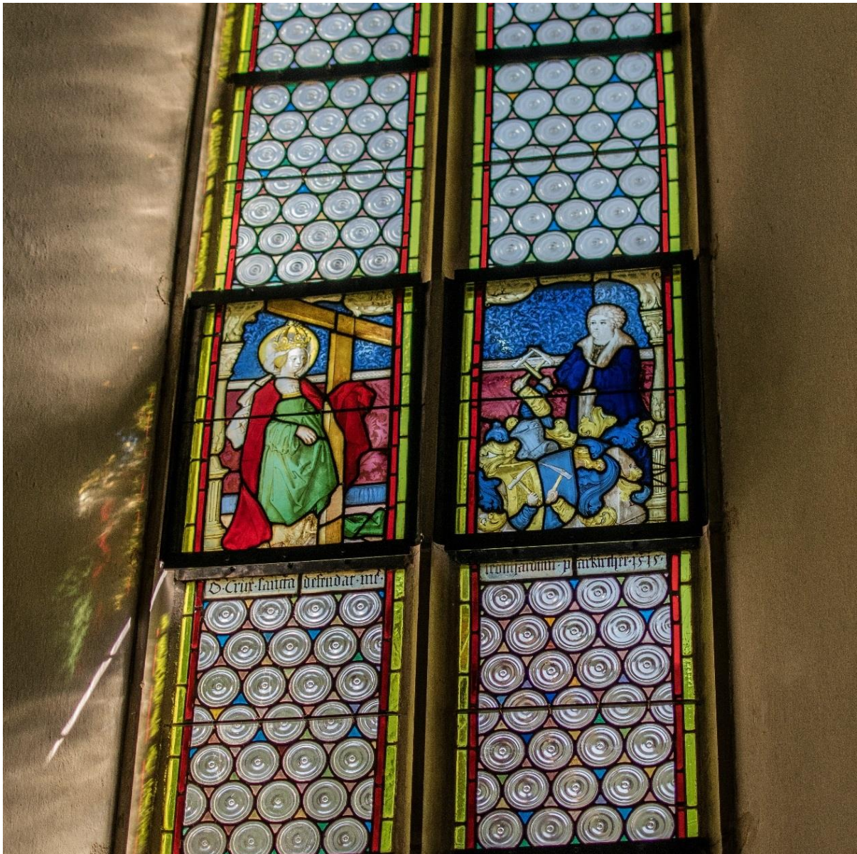
Die Renaissancescheiben nach der Restaurierung mit dem darunterliegenden Spruchband und den umliegenden Scheiben aus gepressten Butzen.
