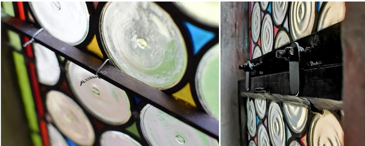
links: Haften aus verzinnem Kupferdraht
