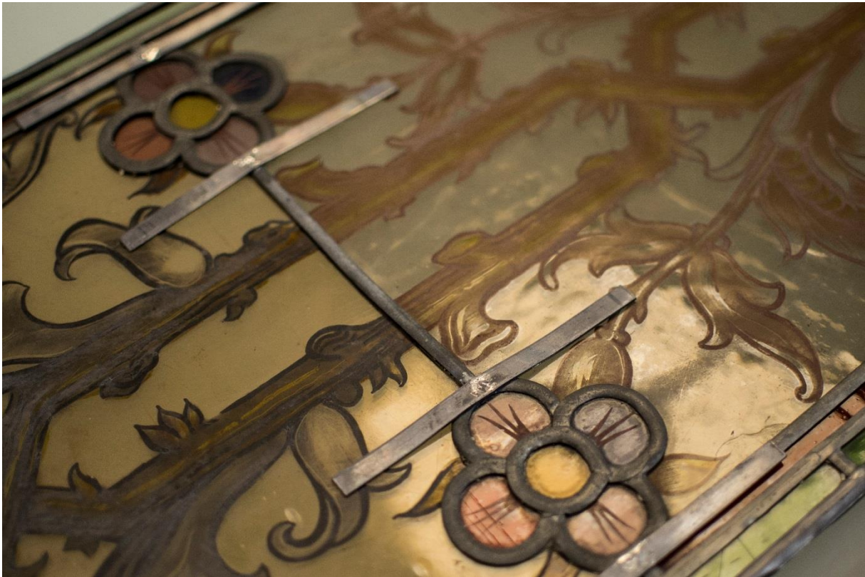
Neu aufgelötete Haften aus Walzblei. Bei den originalen Glasmalerei-Stücken wurde eine bräunliche Konturfarbe benutzt. Im linken Teil des Bildes ist schwarze Kontur erkennbar. Dieses Stück ist offenbar kein Original.
