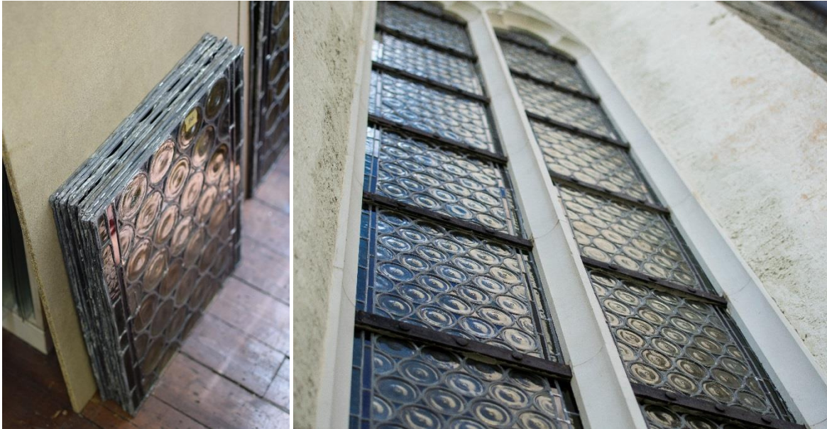
links: Die Bleifelder am Werkstattboden nach der Restaurierung rechts: Die wieder-eingebauten Bleifelder nach der Restaurierung
