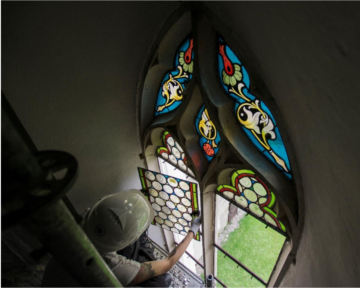
Arbeiten an Fenster sIII
