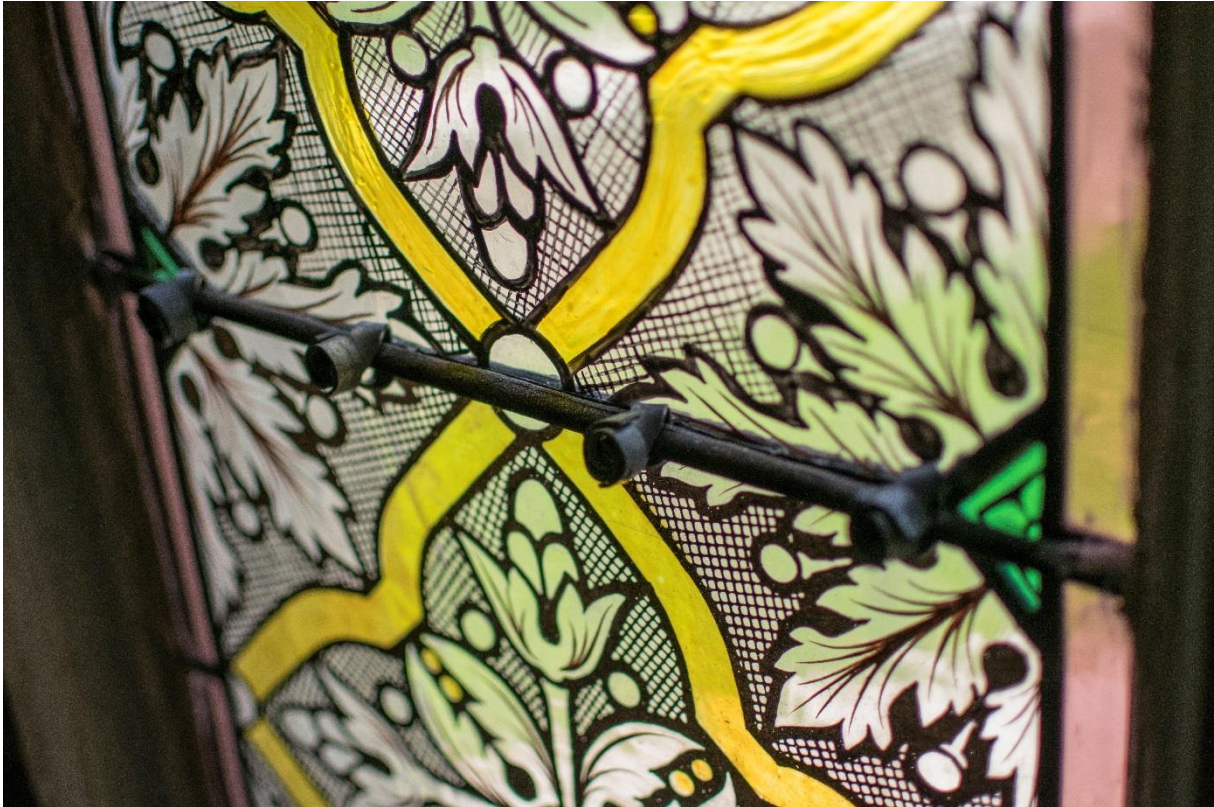
Bleihafte nach der Restaurierung bei Fenster sII
