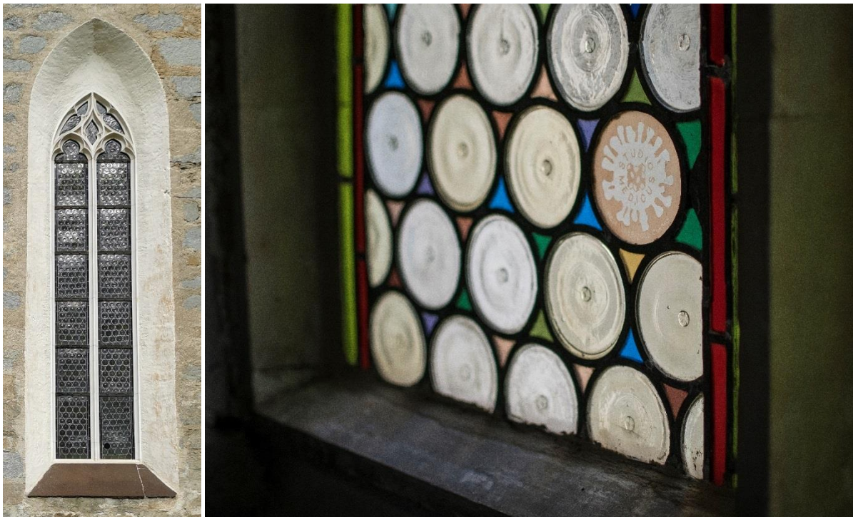
links: Fenster sIII mit Fehlstelle rechts unten
